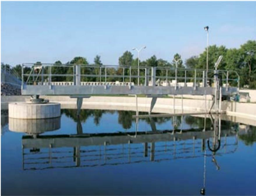
Sedimentatore circolare con carroponte girevole e lame raschiatrici (di fondo e di superficie)
