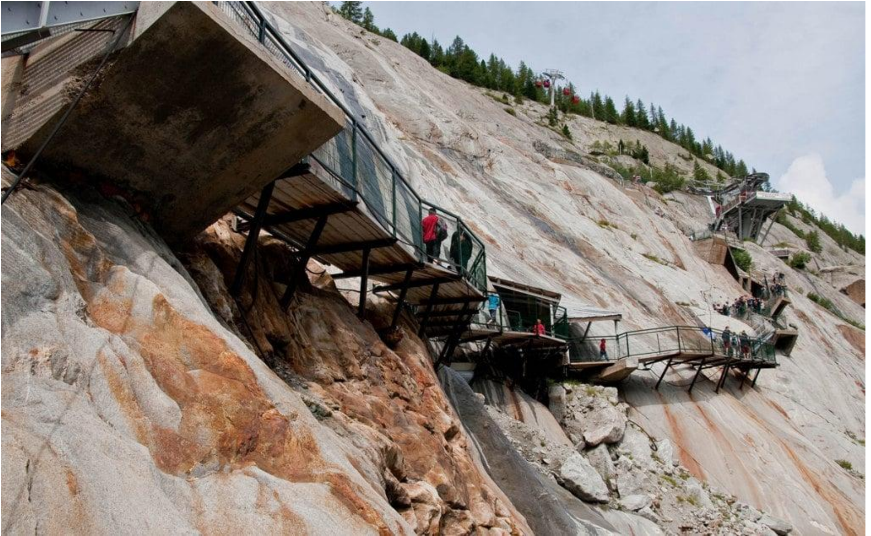
La passerella d'acciaio che dalla stazione di Montenvers conduce alla Mer de Glace, luglio 2018. (Marcello Rossi) Internazionale 5 settembre 2018
